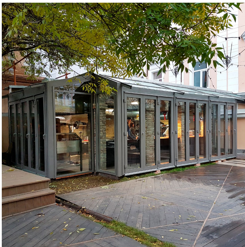
Объект: г. Москва. Кафе Изготовитель конструкций: ООО «Гармония фасада» Серия: S70, F50
