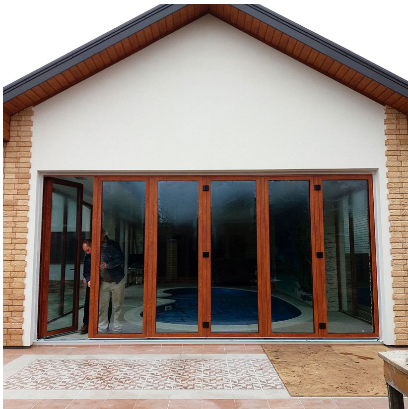
Объект: г. Ставрополь. Коттедж. Изготовитель конструкций: ООО «Идея» Серия: S70
